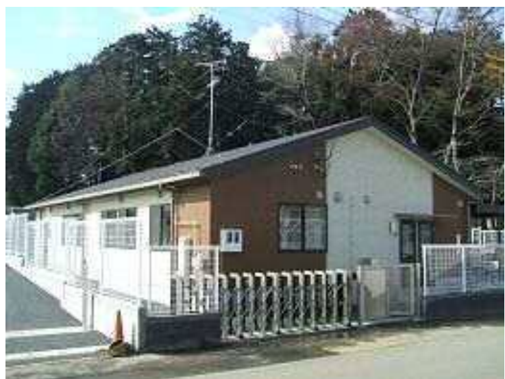
独立施設として整備された 蓮沼第2放課後児童クラブ （平成23年3月完成）
